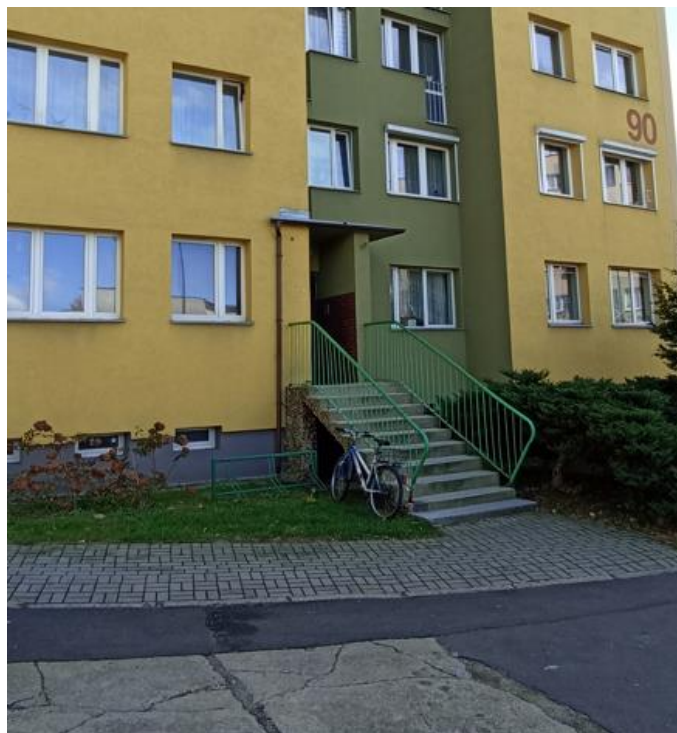
Dojście do budynku
