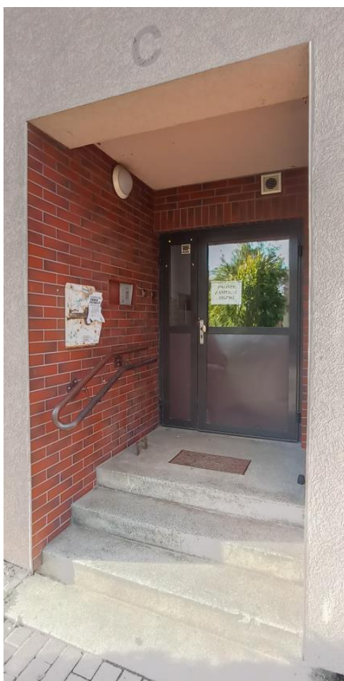
Wejście do budynku
