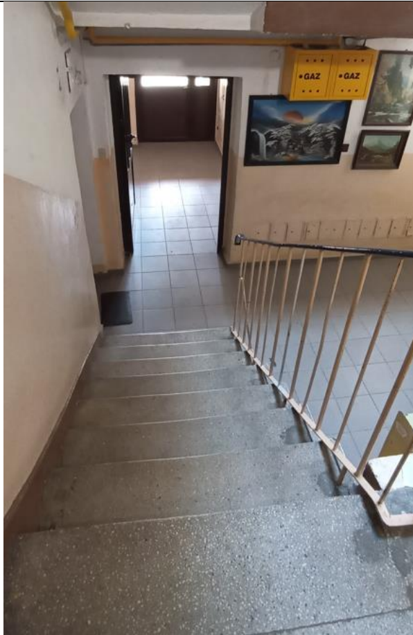
Widok z klatki schodowej na wyjście z budynku
