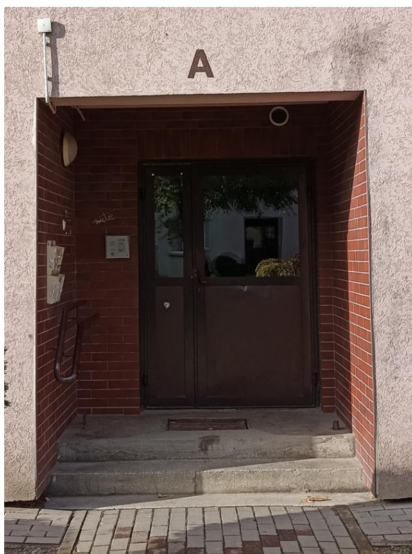
Wejście do budynku
