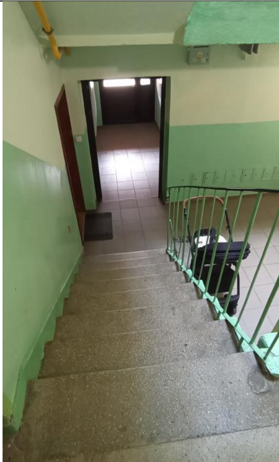
Widok z klatki schodowej na wyjście z budynku
