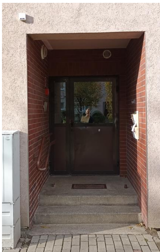
Wejście do budynku
