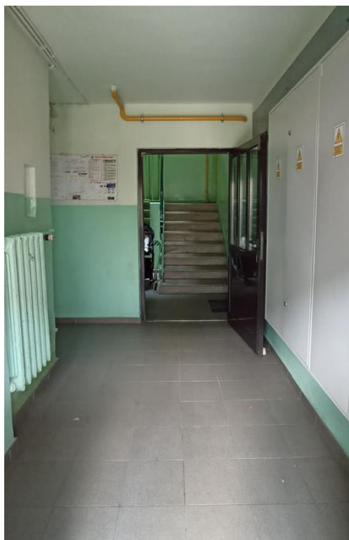
Dojście do klatki schodowej
