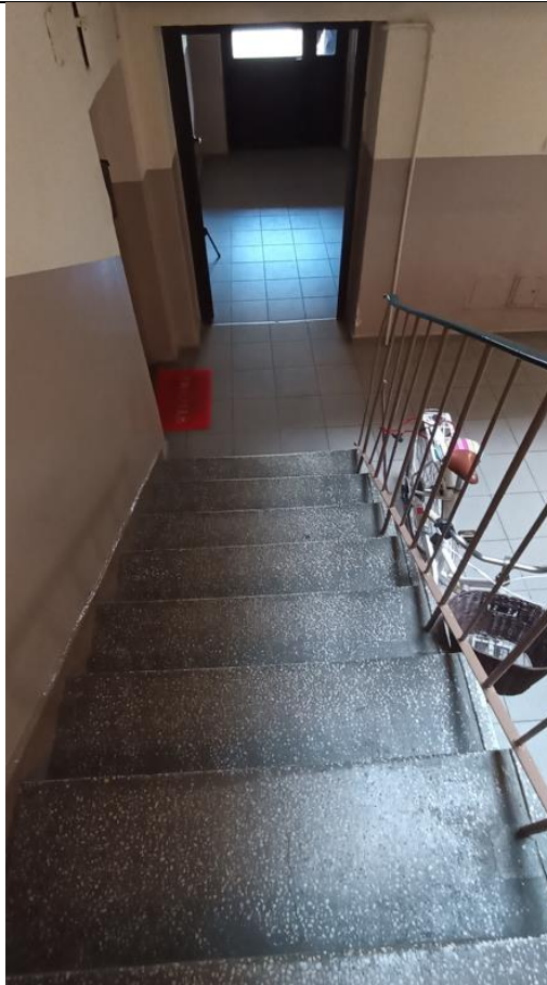
Widok z klatki schodowej na wyjście z budynku
