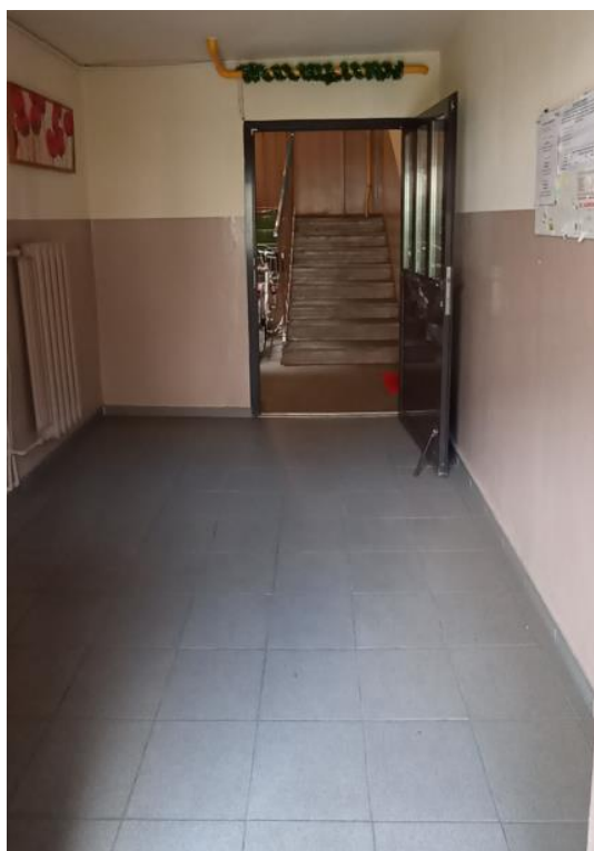
Dojście do klatki schodowej
