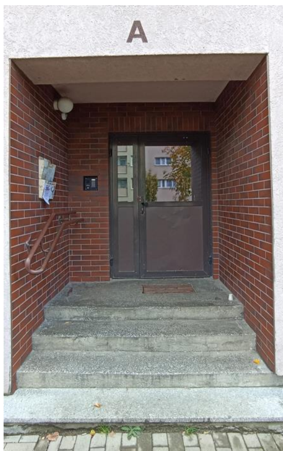
Wejście do budynku
