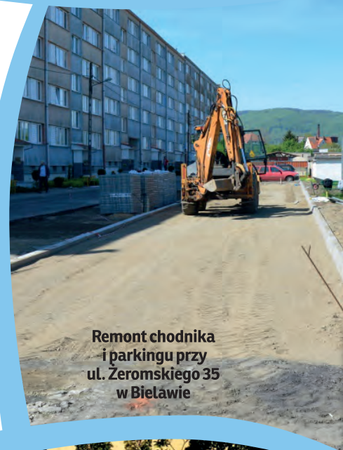
Remont chodnika na os. Włókniarzy w Bielawie
